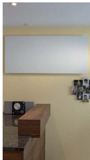
Infrarot-Heizsysteme dienen als vollwertige Heizungslösung; dabei wird nicht die Luft, sondern werden die Körper im Raum erwärmt.
