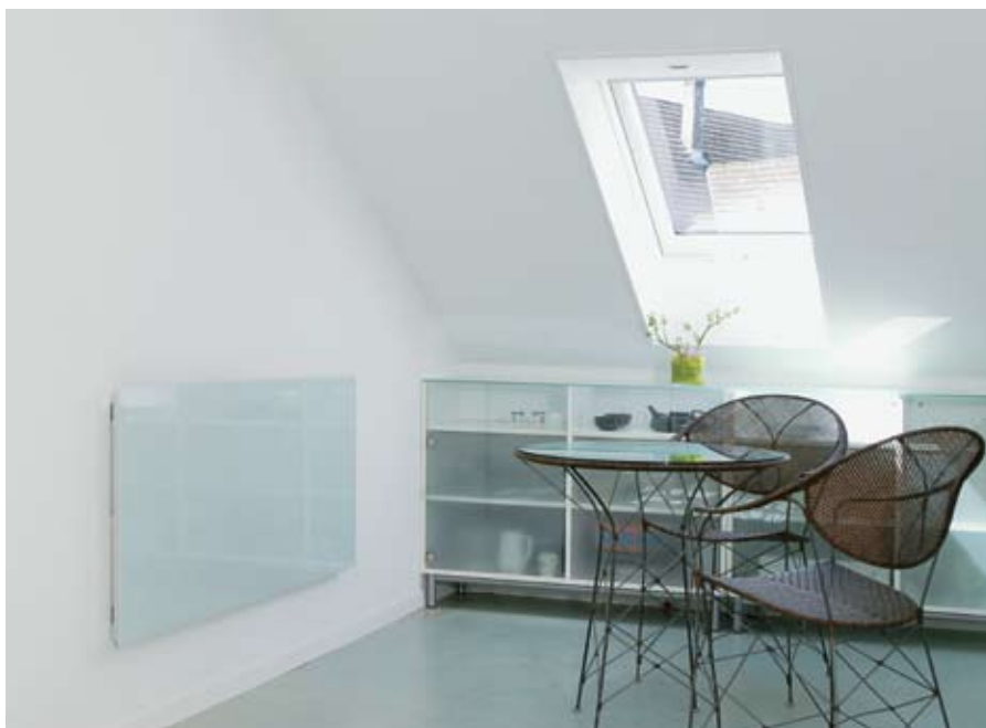
Die Grösse und Leistungsfähigkeit der Infrarotpaneele werden auf Grund der Kubatur und Bausubstanz berechnet.
